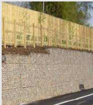
Mury i ściany oporowe
